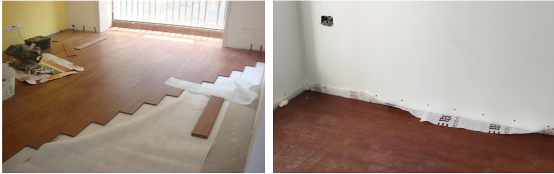
图 8.3-2 防潮垫设置（上翻墙边 50mm）
