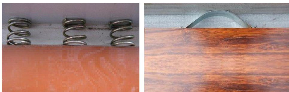
图 8.3-1 面层与墙、柱间隙设置金属弹簧卡
